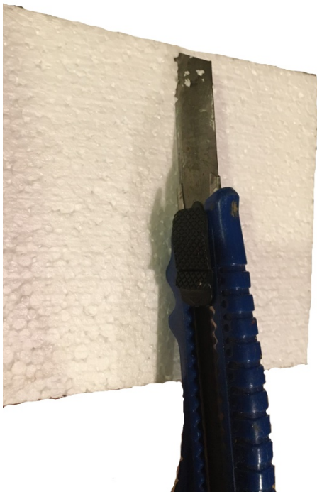
Abbildung 11: Schneiden der Styroporplatten
